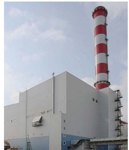
Фото 1. Главный корпус ГТ-надстройки Пермской ТЭЦ-9
