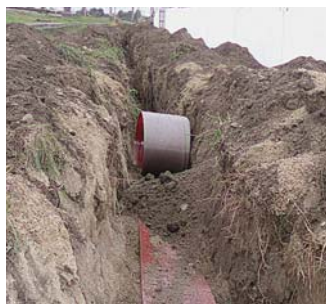
Защитно-сигнальная лента в траншее
