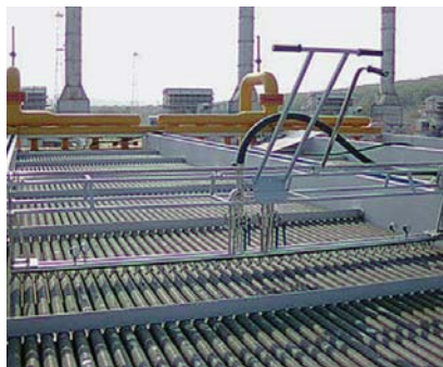
Коллектор для наружной промывки КНП
