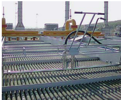
Устройство для наружной промывки УНП Коллектор для наружной промывки КНП
