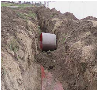
Защитно-сигнальная лента в траншее
