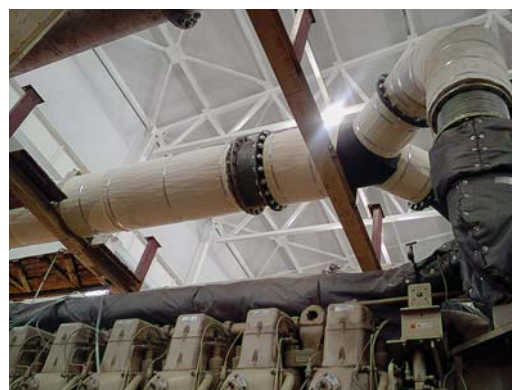
Теплоизоляция выхлопных трубопроводов шумоглушителя выхлопного тракта ГПА на Невском ПХГ
