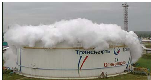
Тушение топливного резервуара
