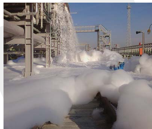
Испытания системы пожаротушения на объекте ТЭК
