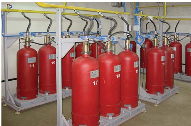
Модульная система газового пожаротушения
