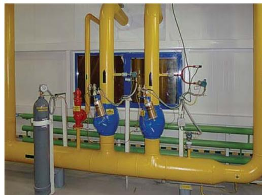
Распределительное реверсивное устройство для подачи газового огнетушащего вещества
