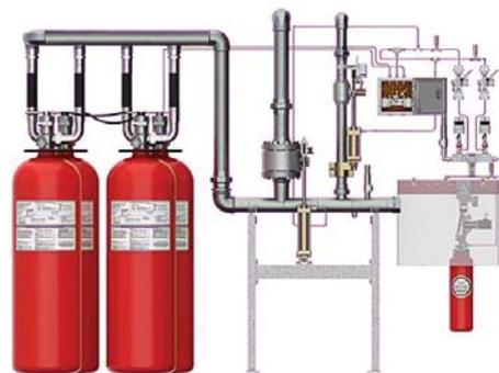
Модули газового пожаротушения
