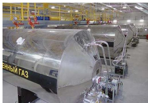
Изотермические модули для жидкой двуокиси углерода
