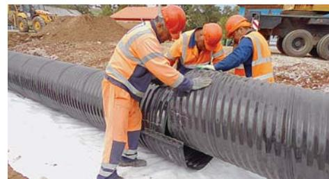
Производственное оборудование позволяет выпускать ГСМТ диаметром 0,3...3,6 м, толщиной металла 1...4,2 мм, размер гофры 68×13 мм, 125×26 мм. Типовой проект серия 3.501.3-187.10.
