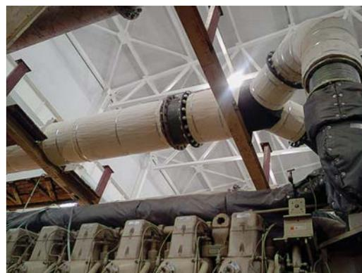
Теплоизоляция выхлопных трубопроводов шумоглушителя выхлопного тракта ГПА на Невском ПХГ
