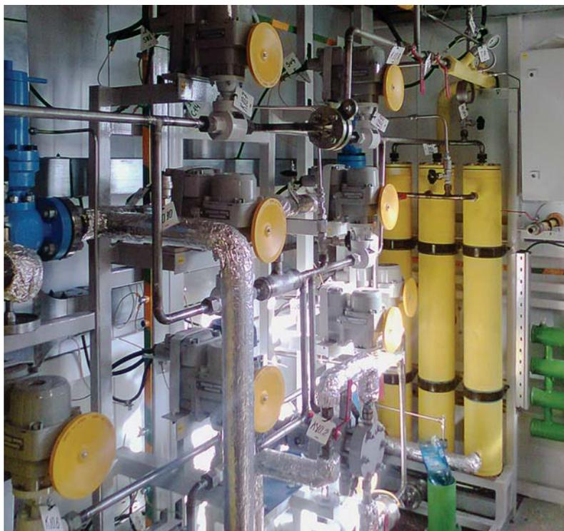
Блок подготовки импульсного газа ГПМ-БПИГ-500/6,3
