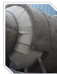
Защитный кожух выхлопного коллектора ГПА
