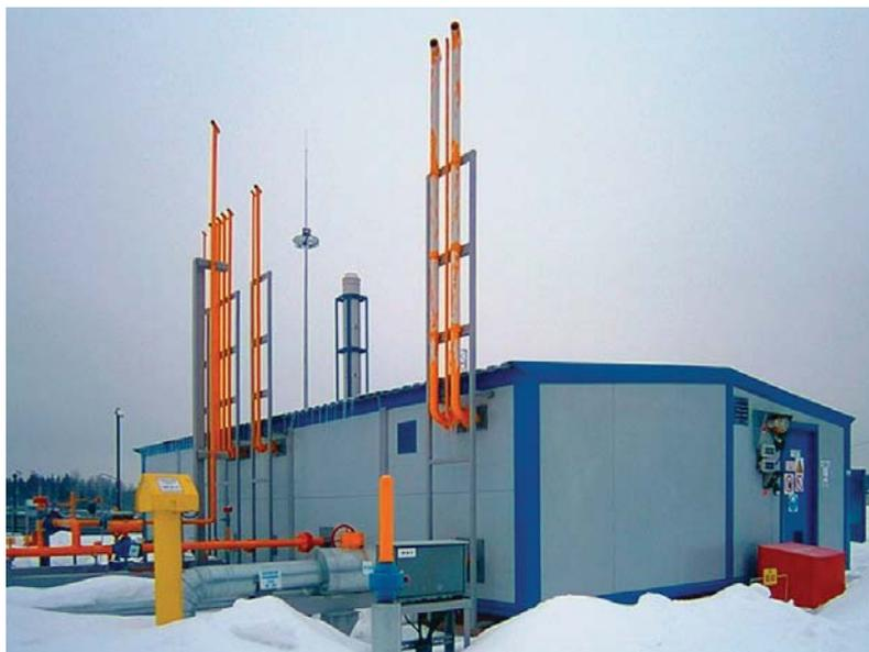
БПТГ может использоваться в качестве газораспределительной станции для подготовки (очистки, подогрева и редуцирования) газа, отбираемого из газопровода высокого давления для газоснабжения котельных, электростанций, установок термического уничтожения отходов, работающих на газе низкого давления.
