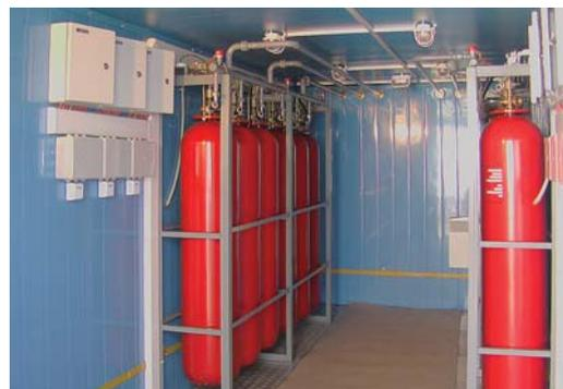
Стойка постоянного контроля утечки CO<sub>2</sub> в модулях газового пожаротушения
