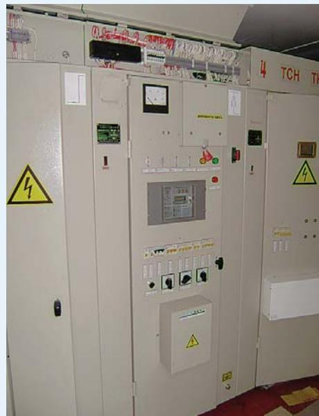
\* КТП мощностью 400 кВА и более изготавливаются по техническим условиям на КТП и имеют габариты, отличные от габаритов БКЭС.
