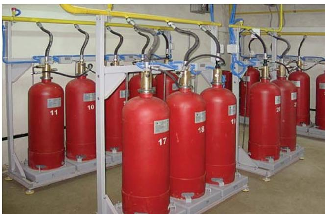
Модульная система газового пожаротушения
