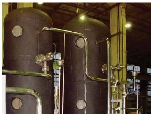
Изоляция уникальных криогенных трубопроводов УСПГ 1,5 материалом Armaflex
