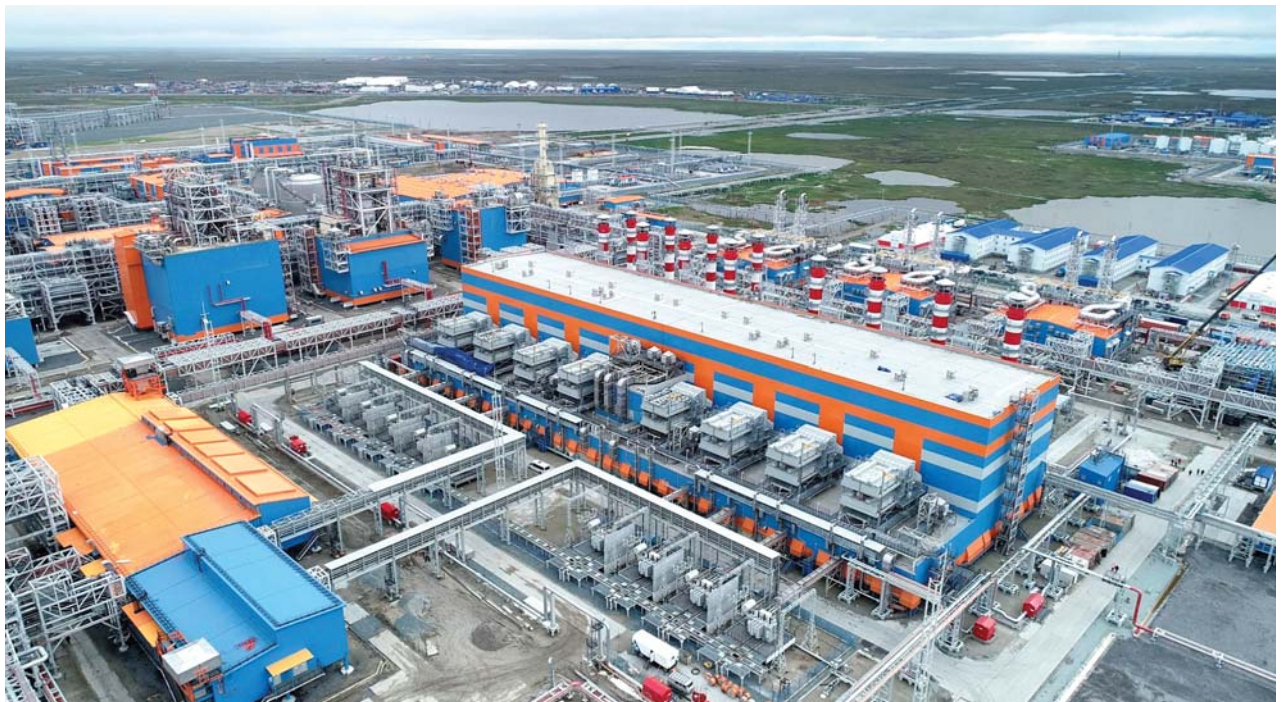
Газотурбинная электростанция общей мощностью 376 МВт на Южно-Тамбейском месторождении, проект «Ямал СПГ». Восемь газотурбинных установок SGT-800 компании Siemens рассчитаны на эксплуатацию при температурах до -60 °С
