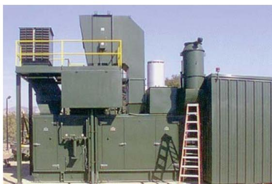
Фото 1. Газотурбинная энергетическая установка GPB15D с ГТД Kawasaki M1A-13D
