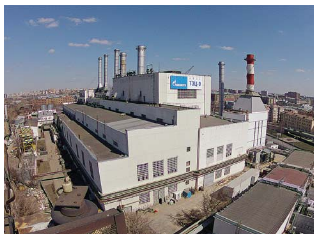
Фото 1. ПГУ-90 с газотурбинным двигателем АЕ64.3А (Ansaldo) на ТЭЦ-9 Мосэнерго
