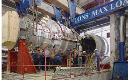
Фото 3. Монтаж газотурбинного двигателя АЕ64.3А (Ansaldo) на ТЭЦ-9 Мосэнерго
