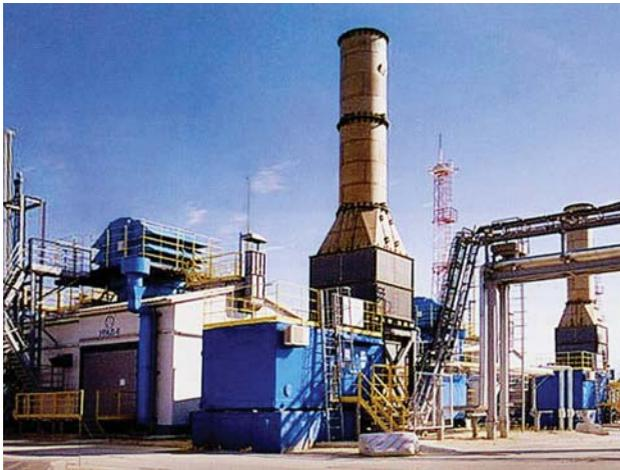
Фото 2. Два GPA-6ДКС на газокompрессорной станции Южно-Приобского месторождения
